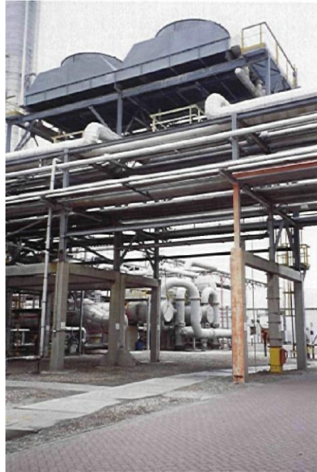
Şekil 2.13: Bir kimyasal proseste yer alan bir kuru hava soğutmalı likit soğutucu örneği [Pers. archive]
